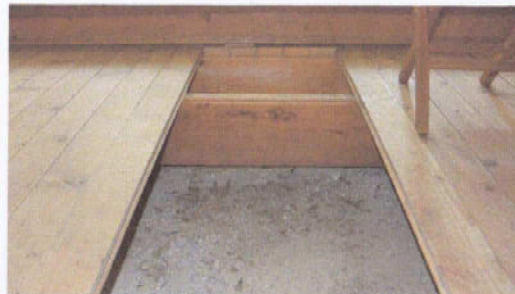
Sondage 2 (Boden im Schiff, vor der Treppe zum Chor)
